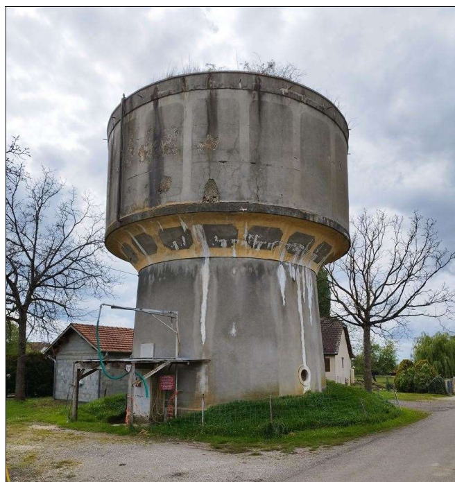
Vue extérieure ancien réservoir
