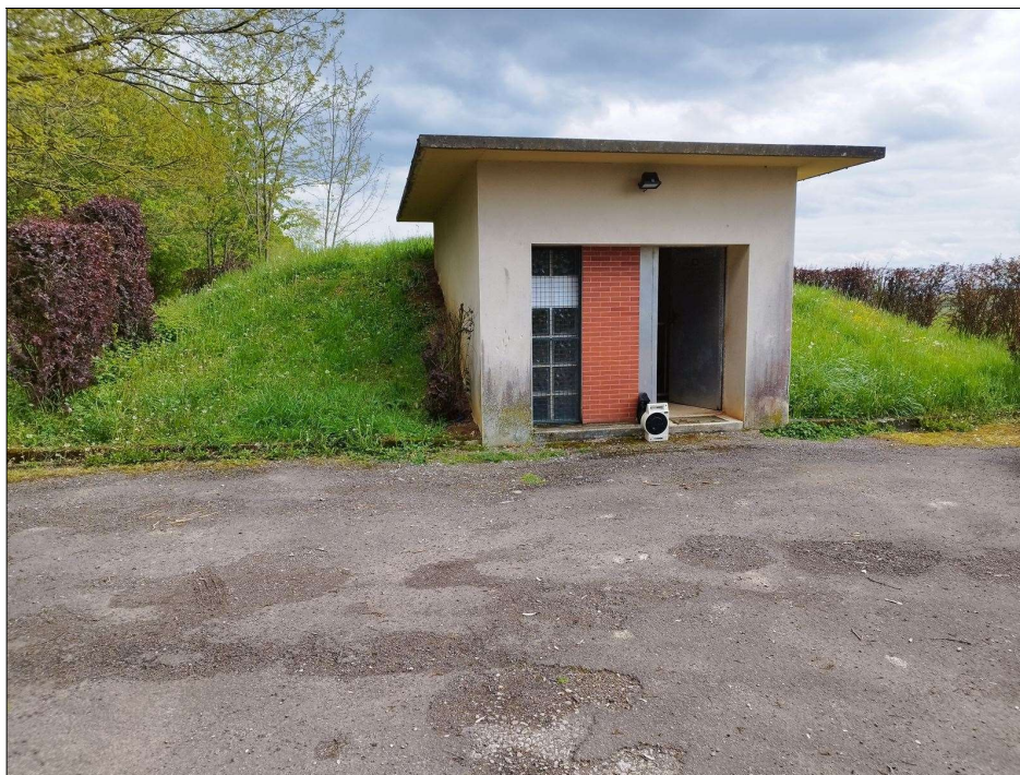
Vue extérieure réservoir de 1996
