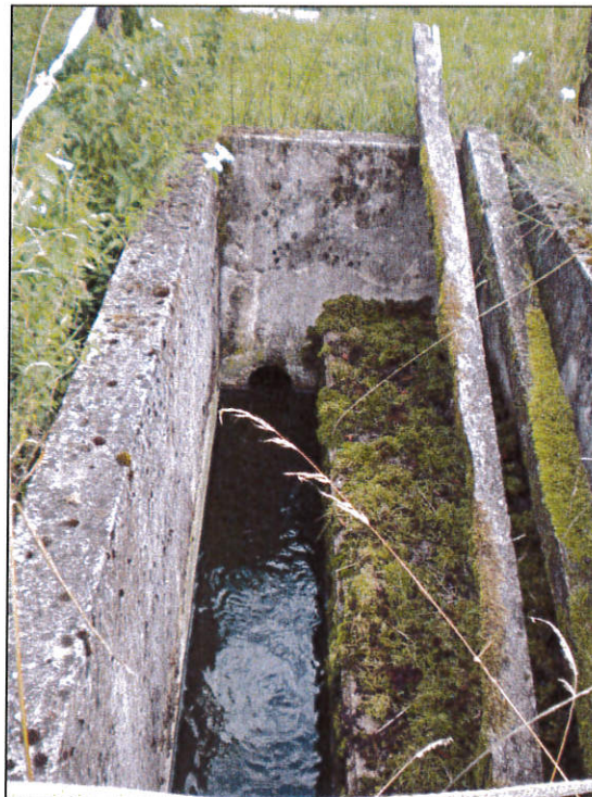
Photographie de l'ouvrage de sortie
