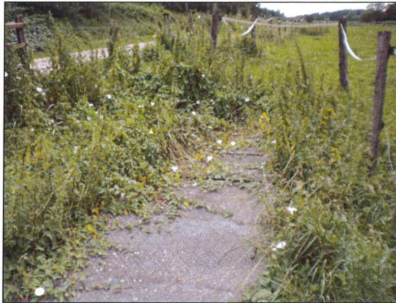
Photographie extérieure du décanteur
