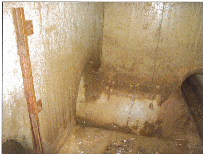
Vue intérieure du DO n°1
